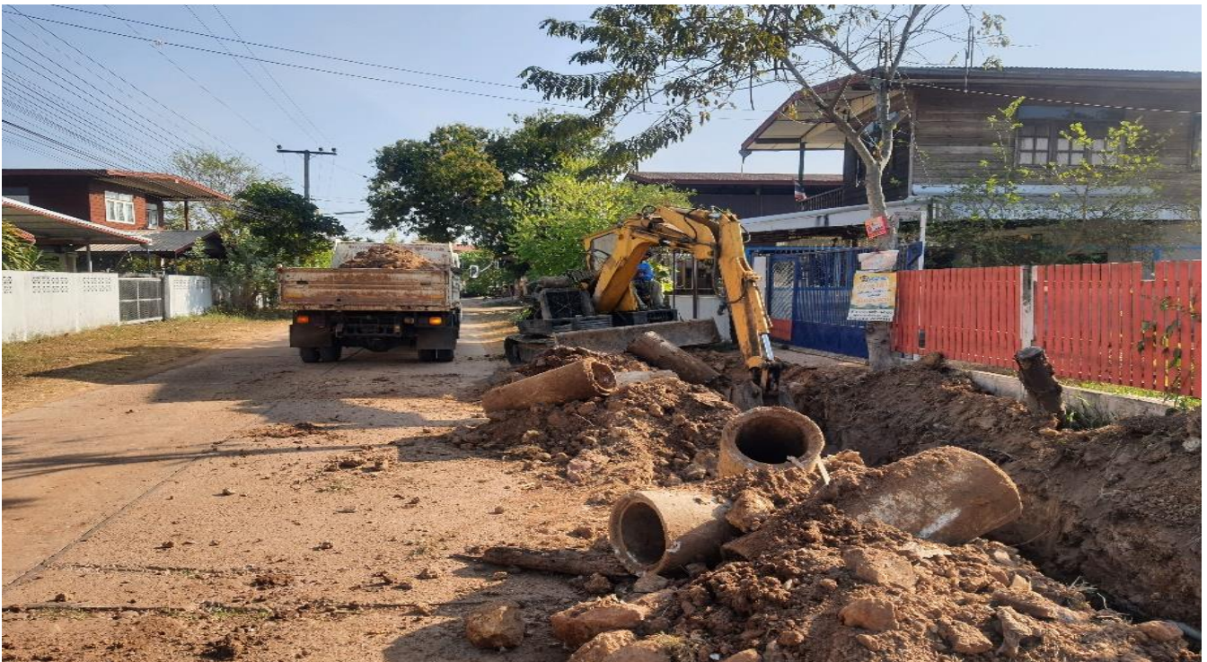
โครงการก่อสร้างรางระบายน้ำหล่อสำเร็จรูป พร้อมฝาปิดภายในหมู่บ้าน บ้านดอนยาวน้อย หมู่ที่ ๖ (เริ่มจาก ต่อดำเดิมหน้าบ้านนางสมจิตร คำพวงชัย)
