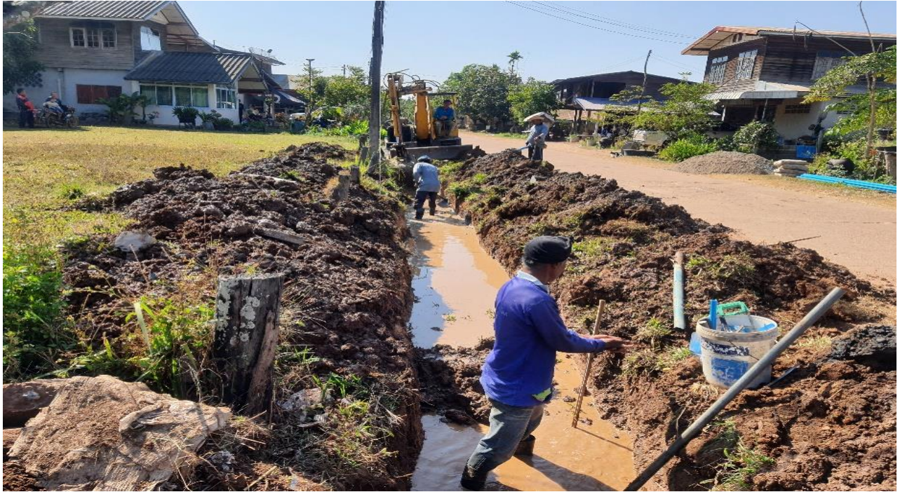
โครงการก่อสร้างรางระบายน้ำหล่อสำเร็จรูป พร้อมฝาปิดภายในหมู่บ้าน บ้านหนองลาด หมู่ที่ ๑ (เริ่มจากสี่แยกข้างถนนลาดยางสายวาริช บ้านขาว - หน้าบ้านนางเคียม สุรินทร์)
