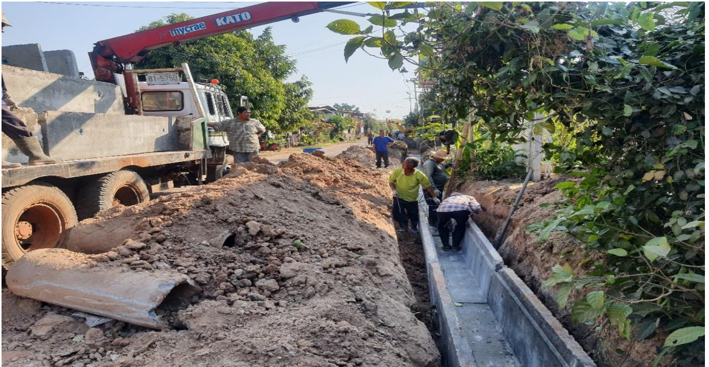
โครงการก่อสร้างรางระบายน้ำหล่อสำเร็จรูป พร้อมฝาปิดภายในหมู่บ้าน บ้านหนองลาด หมู่ที่ ๙ (เริ่มจาก ต่อดำเดิมหน้าบ้านนายคำ โพธิ์มีบุญ - หน้าบ้านนายสุวรรณทอง แก้วคำสอน)
