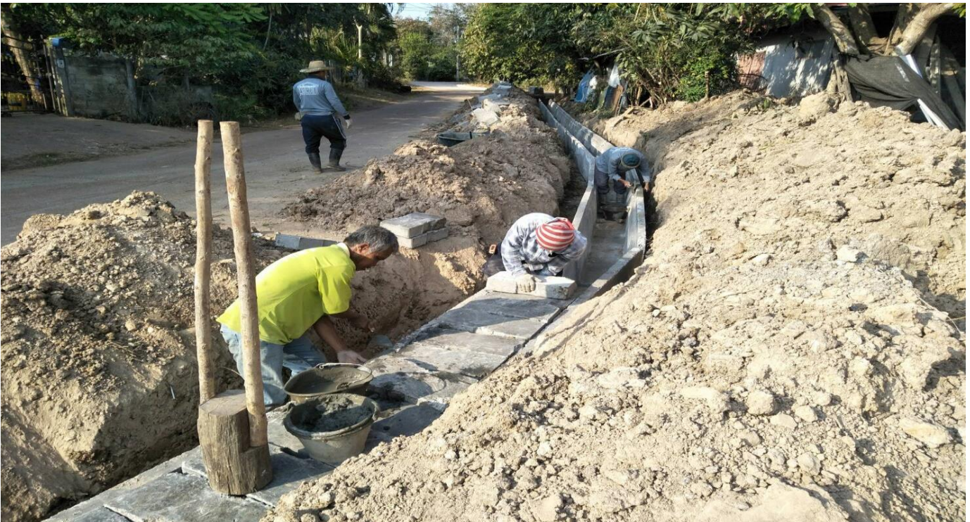
โครงการก่อสร้างรางระบายน้ำหล่อสำเร็จรูป พร้อมฝาปิดภายในหมู่บ้าน บ้านจำปา หมู่ที่ ๕ (เริ่มจาก ต่อตัวเดิมข้างถนนสายบ้านจำปา บ้านค้อเขียว)
