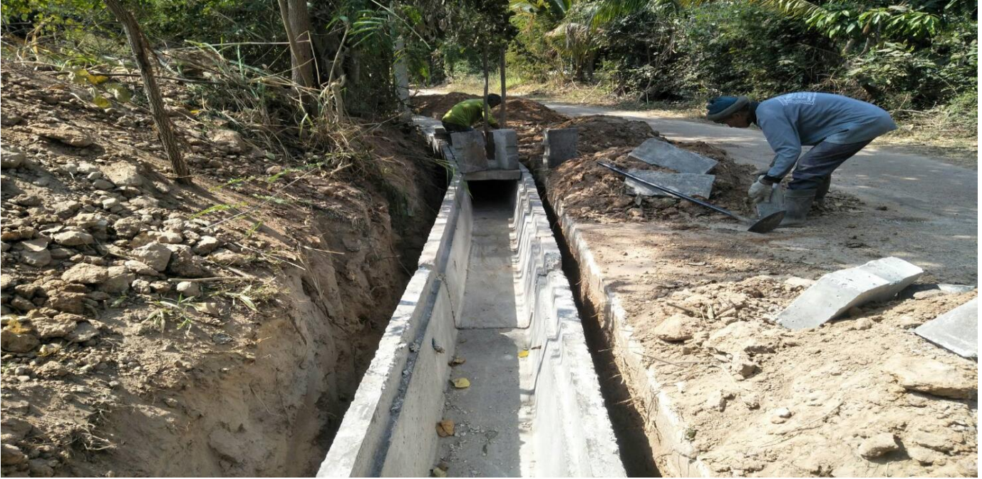
โครงการก่อสร้างรางระบายน้ำหล่อสำเร็จรูป พร้อมฝาปิดภายในหมู่บ้านจำปา หมู่ที่ ๑๑ (เริ่มจากตัวเดิมข้างถนนสายจำปาคำปู้ตา)
