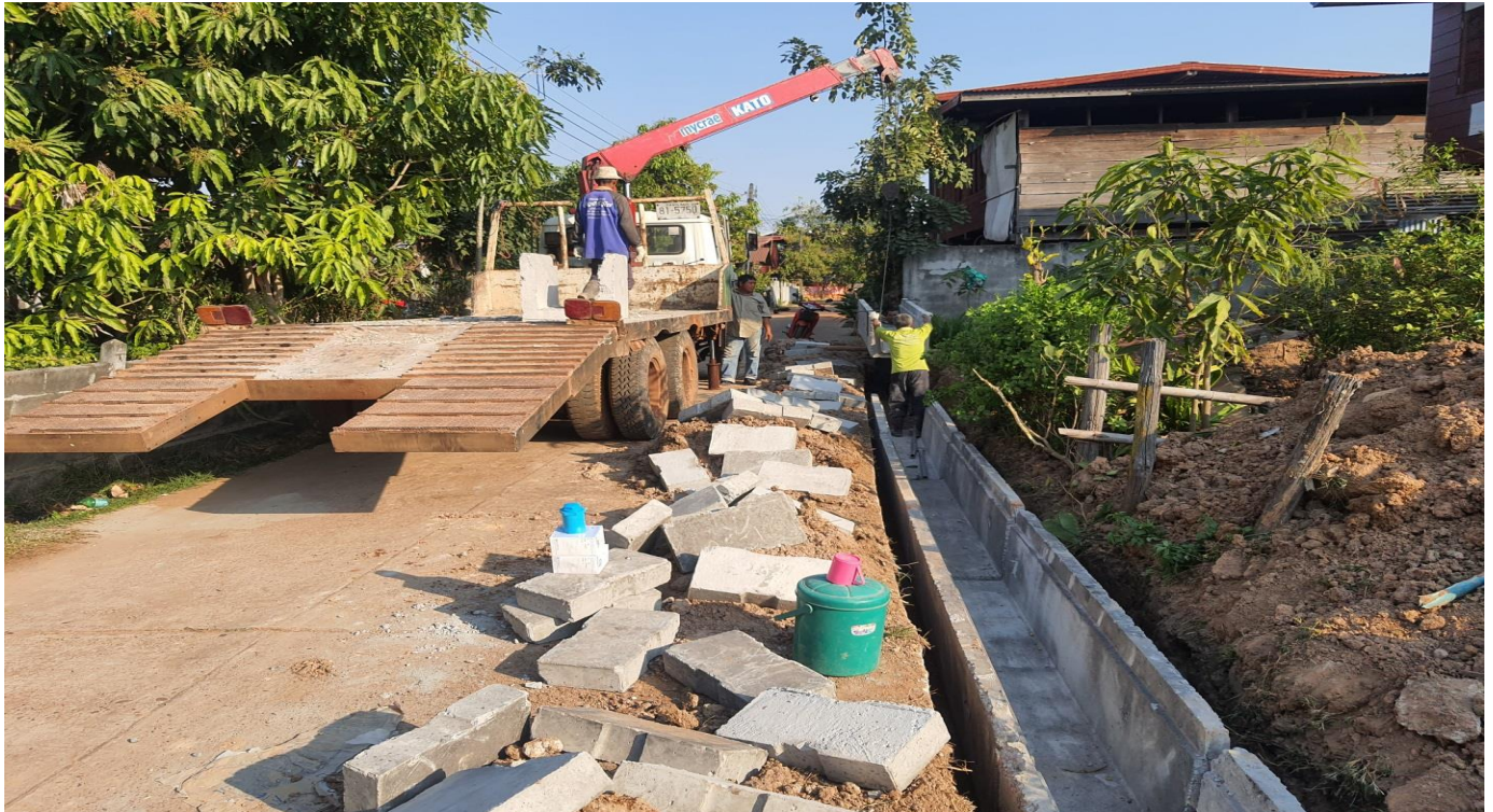
โครงการก่อสร้างรางระบายน้ำหล่อสำเร็จรูป พร้อมฝาปิดภายในหมู่บ้าน บ้านหนองลาด หมู่ที่ ๑ (เริ่มจาก ต่อดำเดิม - หน้าบ้านนายบรรเทา เหล่าพรม)
