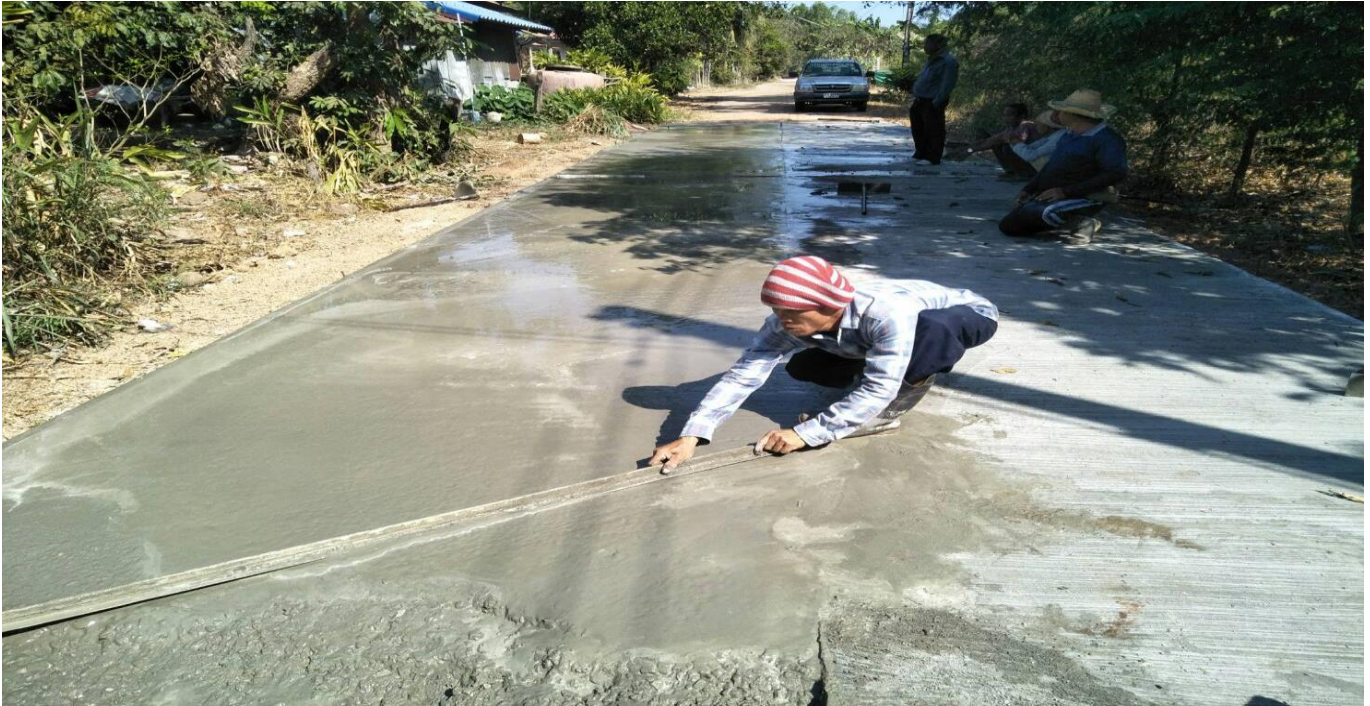
โครงการก่อสร้างถนนคอนกรีตเสริมเหล็กบ้านหนองแขวงน้อย หมู่ ๗ (ต่อจากตัวเดิมบริเวณบ้านนางสุดใจ ศรีลาตัด)
