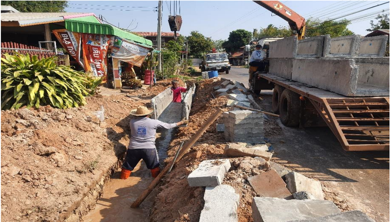
โครงการก่อสร้างรางระบายน้ำหล่อสำเร็จรูป พร้อมฝาปิดภายในหมู่บ้าน บ้านหนองบาก หมู่ที่ ๘ (เริ่มจาก ต่อตัวเดิม - หน้าบ้านนายวังชัย สำนึก - หน้าบ้านนายสาคร สำนึก)
