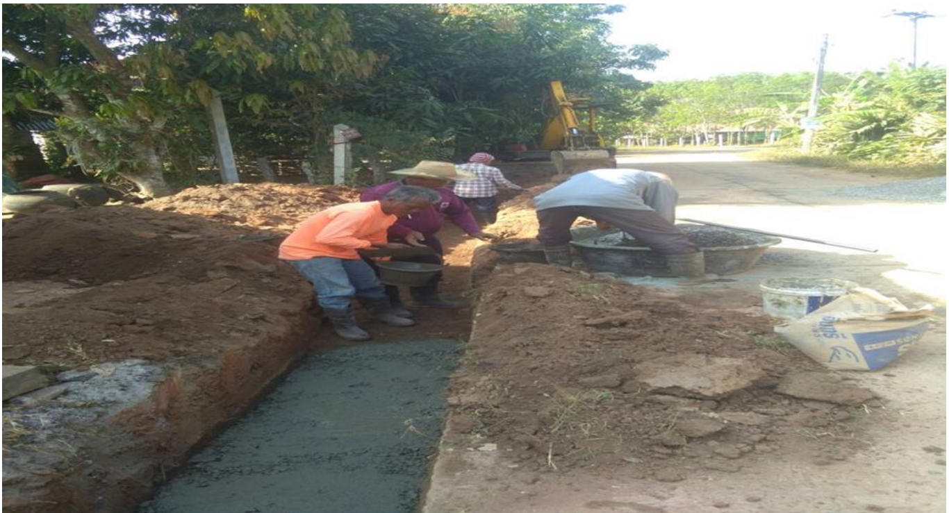
โครงการก่อสร้างรางระบายน้ำหล่อสำเร็จรูป พร้อมฝาปิดภายในหมู่บ้าน บ้านค้อ หมู่ที่ ๒ (ต่อจากตัวเดิม ข้างถนนสายบ้านค้อ - บ้านเล่า)
