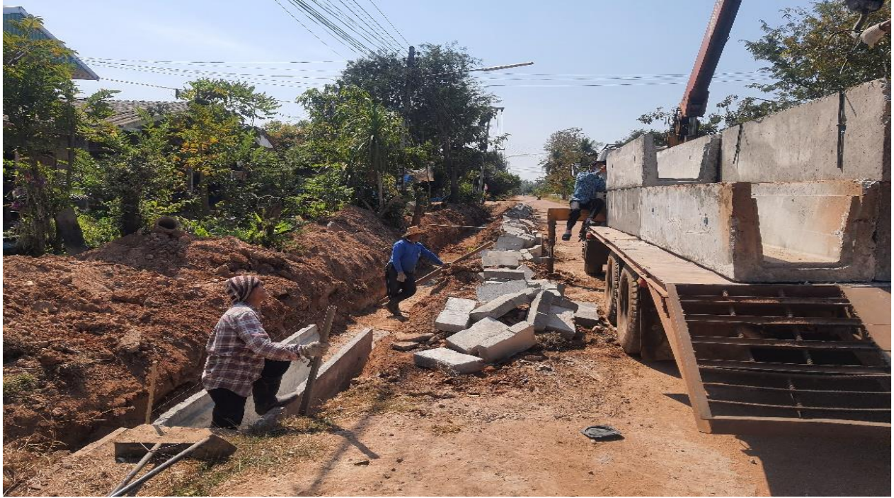
โครงการก่อสร้างรางระบายน้ำหล่อสำเร็จรูป พร้อมฝาปิดภายในหมู่บ้าน บ้านดอนยาวใหญ่ หมู่ที่ ๓ (เริ่มจาก ต่อตัวเดิม - หน้าบ้านนางมาลัย โอดพล)
